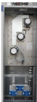
Abbildung 17: Anschlusstechnik Spannungssensor
