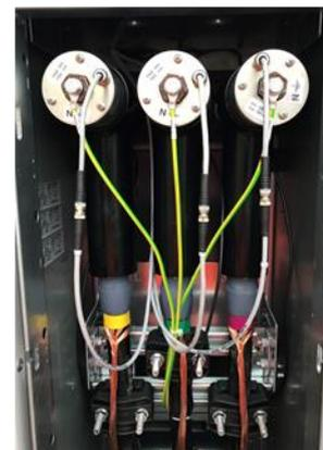
Abbildung 17: Anschlusstechnik Spannungssensor
